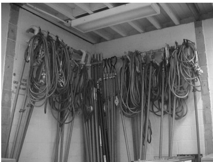
Figura 10-10 Puentes de puesta a tierra.
