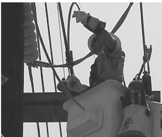
Figura 10-11 Mantenimiento de Distribución.
