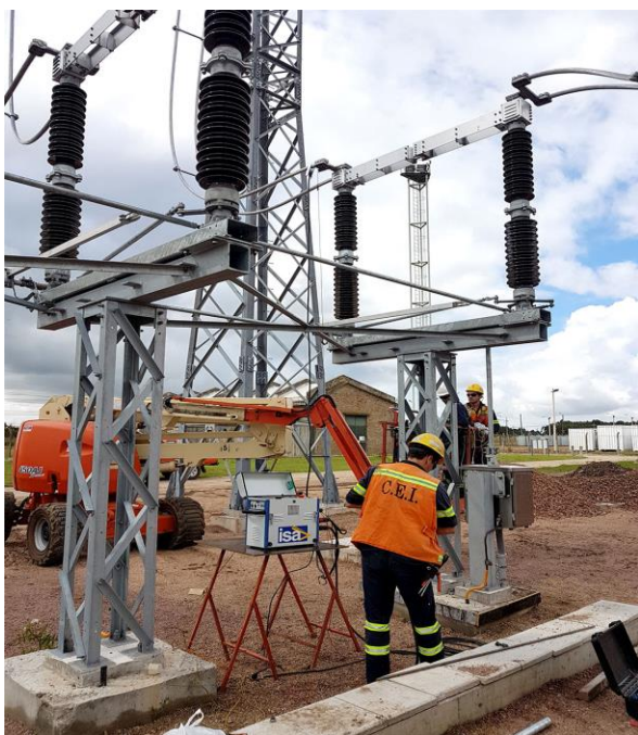
Figura 10-12 Mantenimiento de Subestaciones en vivo.
