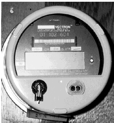
Figura 6-6 Medidor de kWh de estado sólido.
