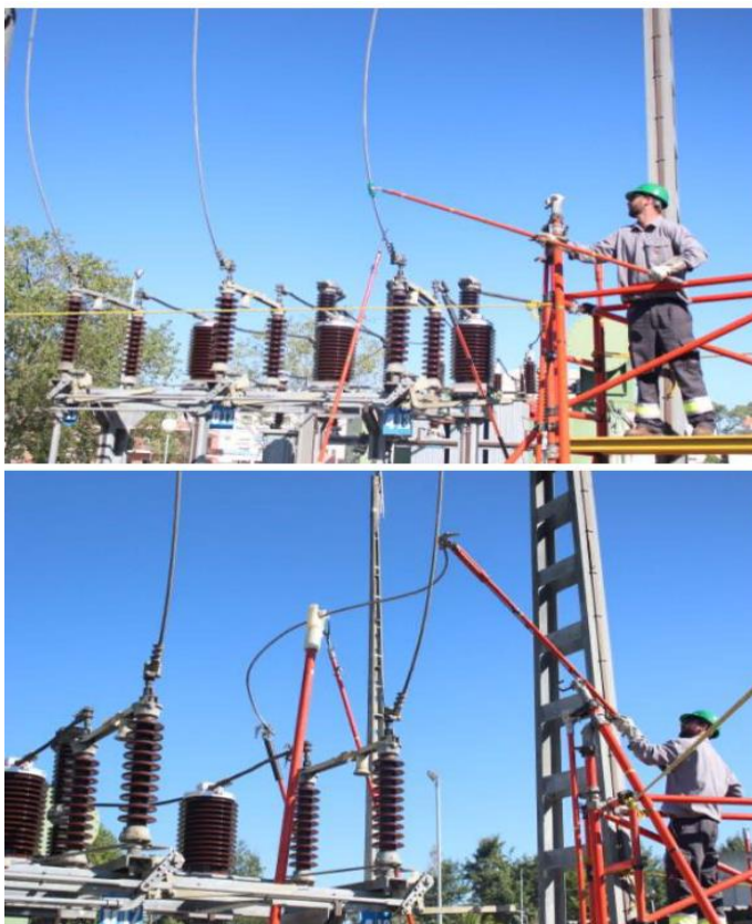
Figura 10-8. Mantenimiento de la línea viva
