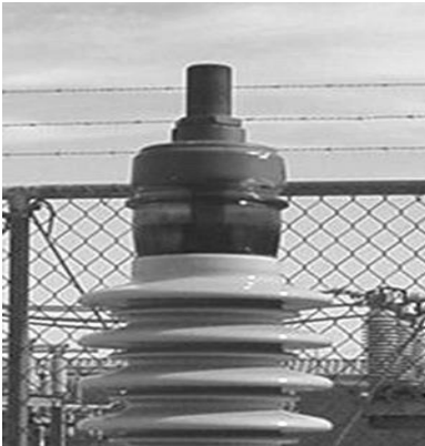
Figura 4-7 Indicador de nivel de aceite del Bushing
