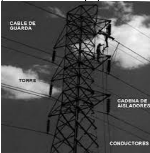
Figura 3-1 Línea de transmisión.
