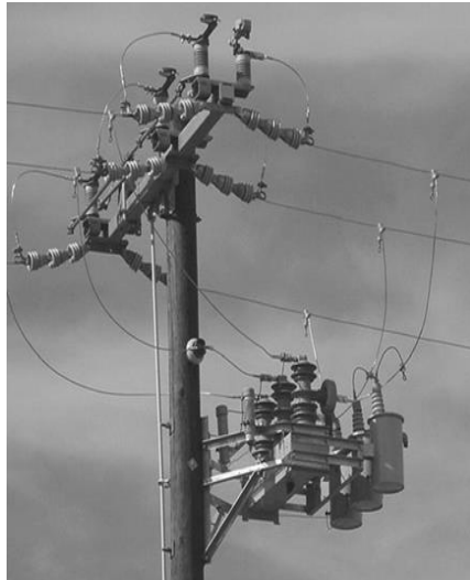
Figura 6-12 Medición primaria aérea.
